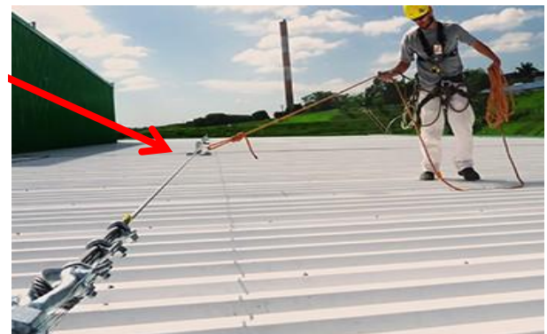
Ponto de Ancoragem
